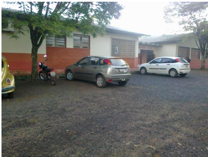
Fotografia1: pátio para estacionamento e acesso à escola. Fonte: Fotografia tirada pela pesquisadora.
