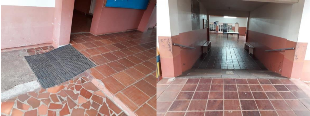
Fotografia 3 e 4: rampa de acesso e corredor com barra nas paredes. Fonte: Fotografia tirada pela pesquisadora.
